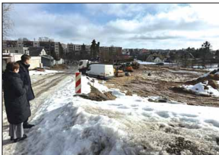
Apžiūrimi automobilių stovėjimo aikštelės Revuonos g. įrengimo darbai.
