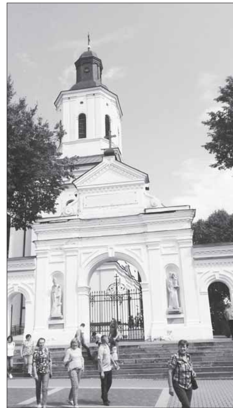
Telšių Šv. A.Paduviečio katedra – įspūdinga iš išorės ir viduje.
